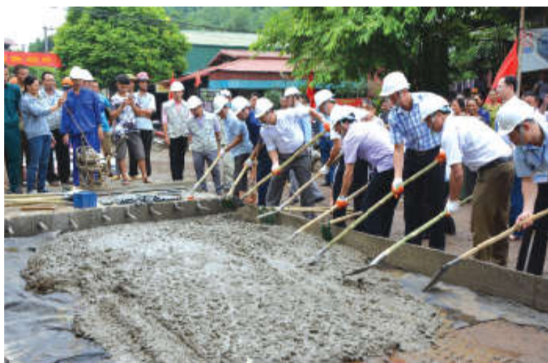
Thi công đường giao thông tại xã Châu Quế Hạ.
