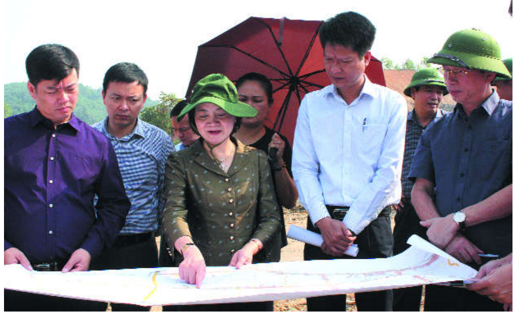
Đồng chí Bí thư Tỉnh ủy Phạm Thị Thanh Trà cùng đoàn công tác kiểm tra tiến độ thi công Dự án đường nối Quốc lộ 32 C với đường cao tốc Nội Bài - Lào Cai.
