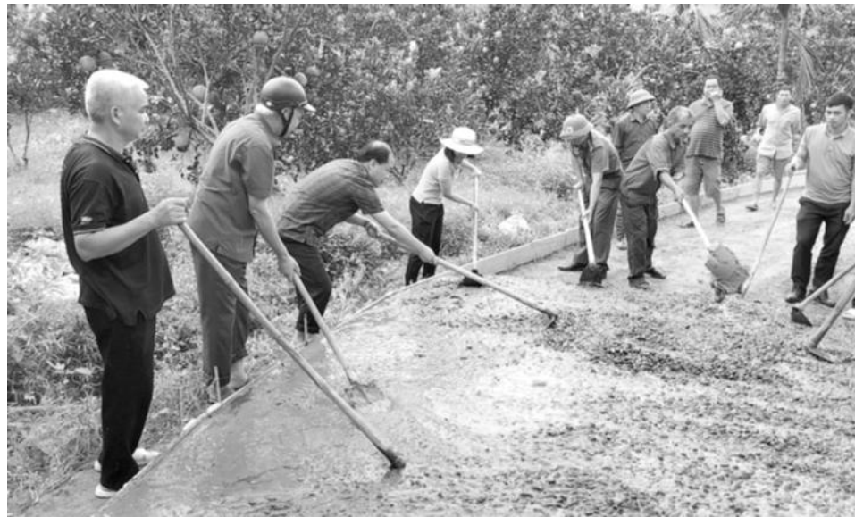
Nhân dân xã Vũ Linh, huyện Yên Bình tham gia bê tông hóa đường giao thông nông thôn.
