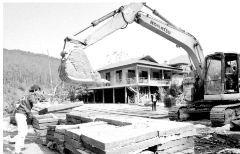
Công ty cổ phần Đầu tư và Xây lắp Hưng Việt - UDIC đang sản xuất trên 1.000 tấm bản gia công ống cống trên tuyến đường Trạm Tấu - Bắc Yên.
