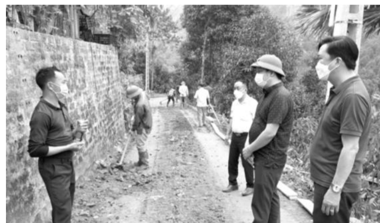
Lãnh đạo huyện Văn Yên kiểm tra công tác kiên cố hóa đường giao thông nông thôn tại xã Phong Dụ Hạ.
