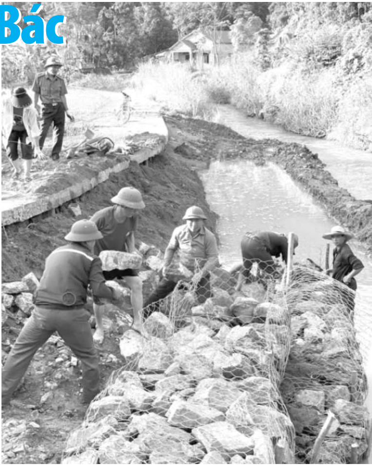
Cán bộ xã Yên Thái tham gia cùng nhân dân kè chống sạt lở tuyến đường giao thông tại thôn Quế Ngoại.
