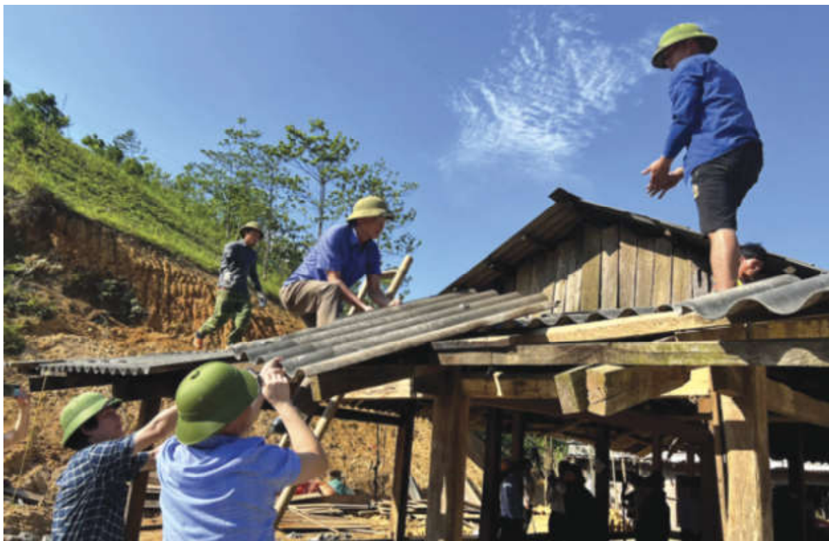
Nhiều địa phương đang dồn toàn lực phấn đấu hoàn thành xong Đề án xóa nhà tạm, nhà dột nát năm 2025 trước ngày 30/6 (ảnh minh họa).
