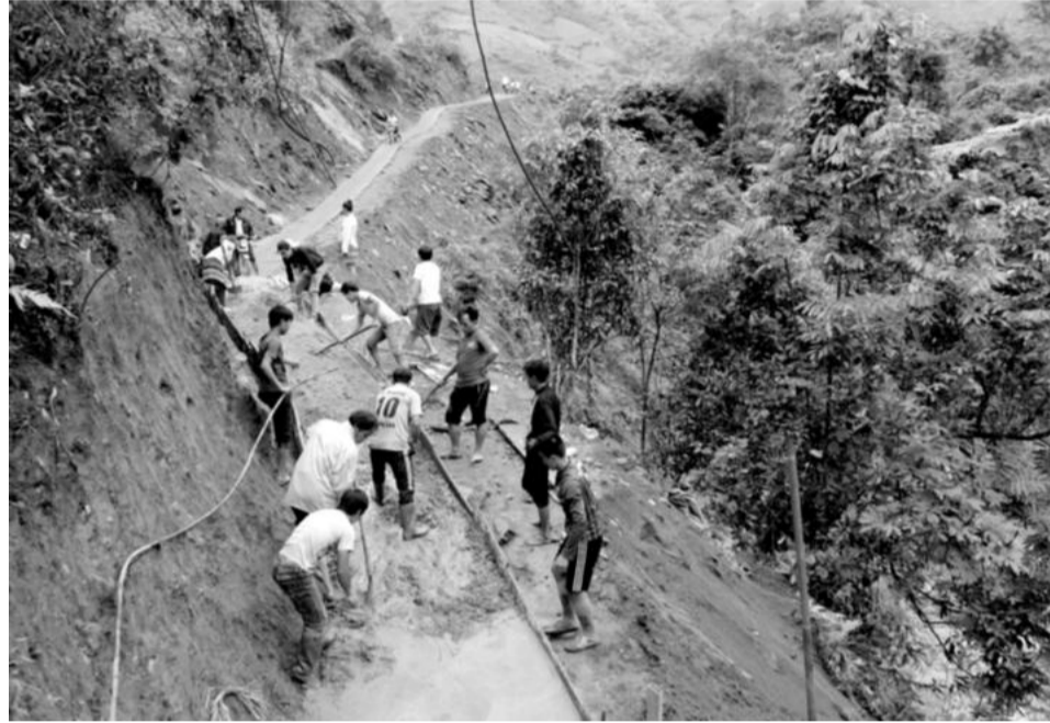
Đông bào Mông xã Túc Đán, huyện Trạm Tấu chung sức bê tông hóa đường giao thông nông thôn.
